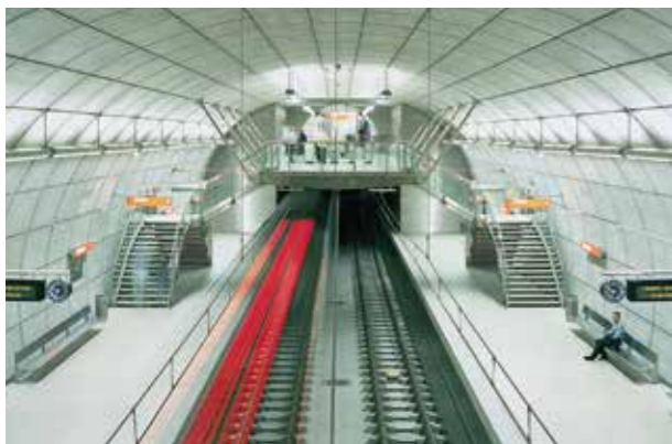
Estaciones de metro, Bilbao, España
